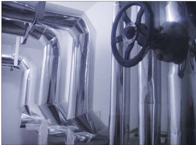
几根粗管道穿过地下室的狭窄空间,使本来就不大的地下室更加拥挤。
