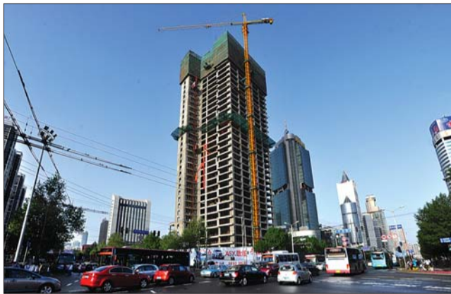
已经封顶的大众传媒大厦。本报记者 徐延春 摄
