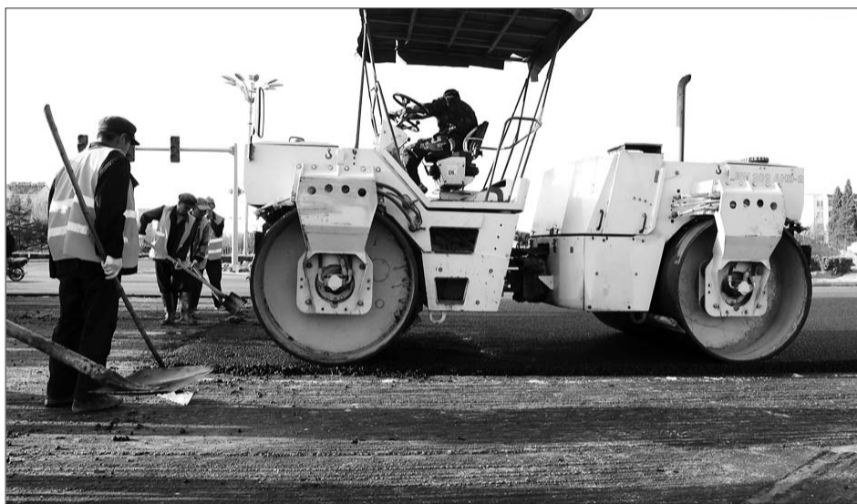
25日下午,在胜利大街上,市政工作人员正在为马路铺设沥青。本报记者小杰摄
