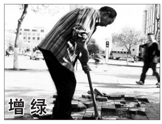
增绿 25日下午,德兴大道(天衢路至大学路段)路边的部分方砖被启开,据了解,这是德州市7条主干道一路一景绿化改造计划的最后一站,改造面积4500平方米,增加种植双排行道树200株。 本报记者 常学艺 王衍 摄影报道
