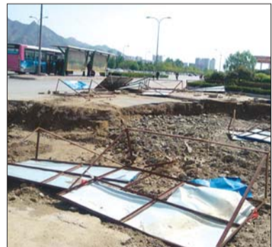
十多个工地警示牌被刮得东倒西歪。 本报记者 刘来
