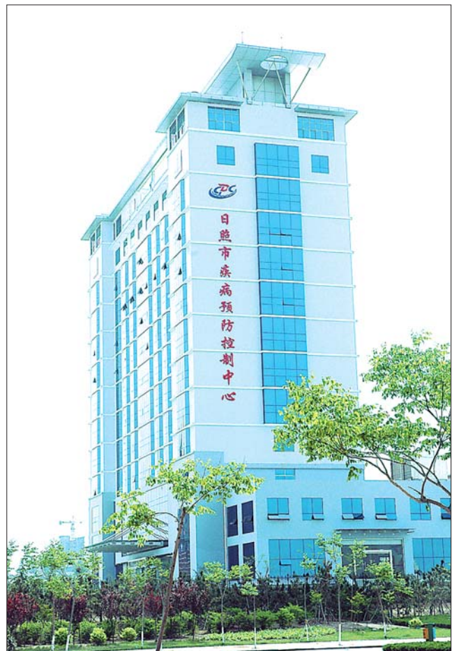
市疾控中心大楼
