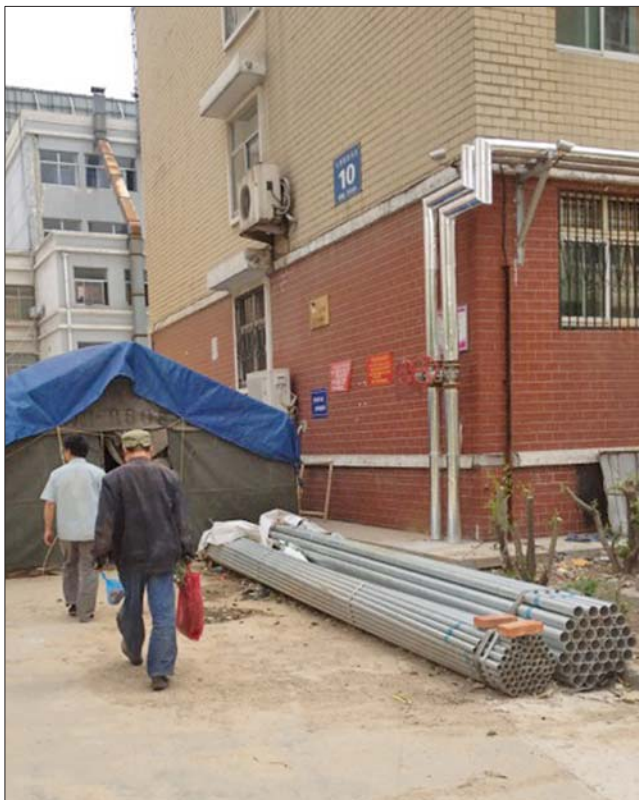
在七里堡小区东区内,采暖设施安装已接近尾声。 本报记者 王光照 摄
