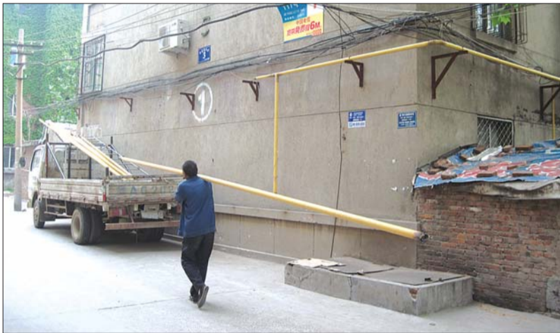
施工人员正在拆卸煤气管道。 吴金彪 摄
