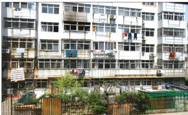
事发居民楼的楼下被居民围挡起来。本报记者 杨宁 摄
