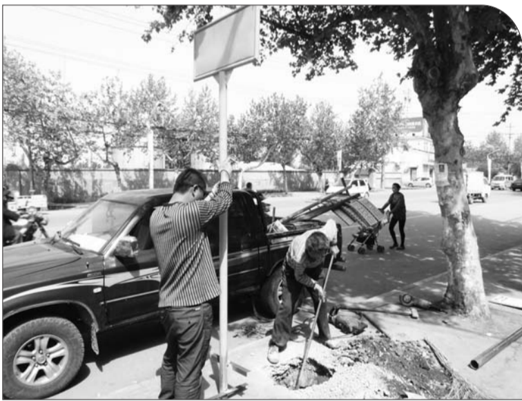
解放南路上,工作人员正在更换公交站牌。
