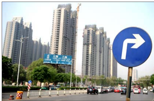
山西省太原市一处正在建设的住宅区(5月3日摄)。 新华社 发
