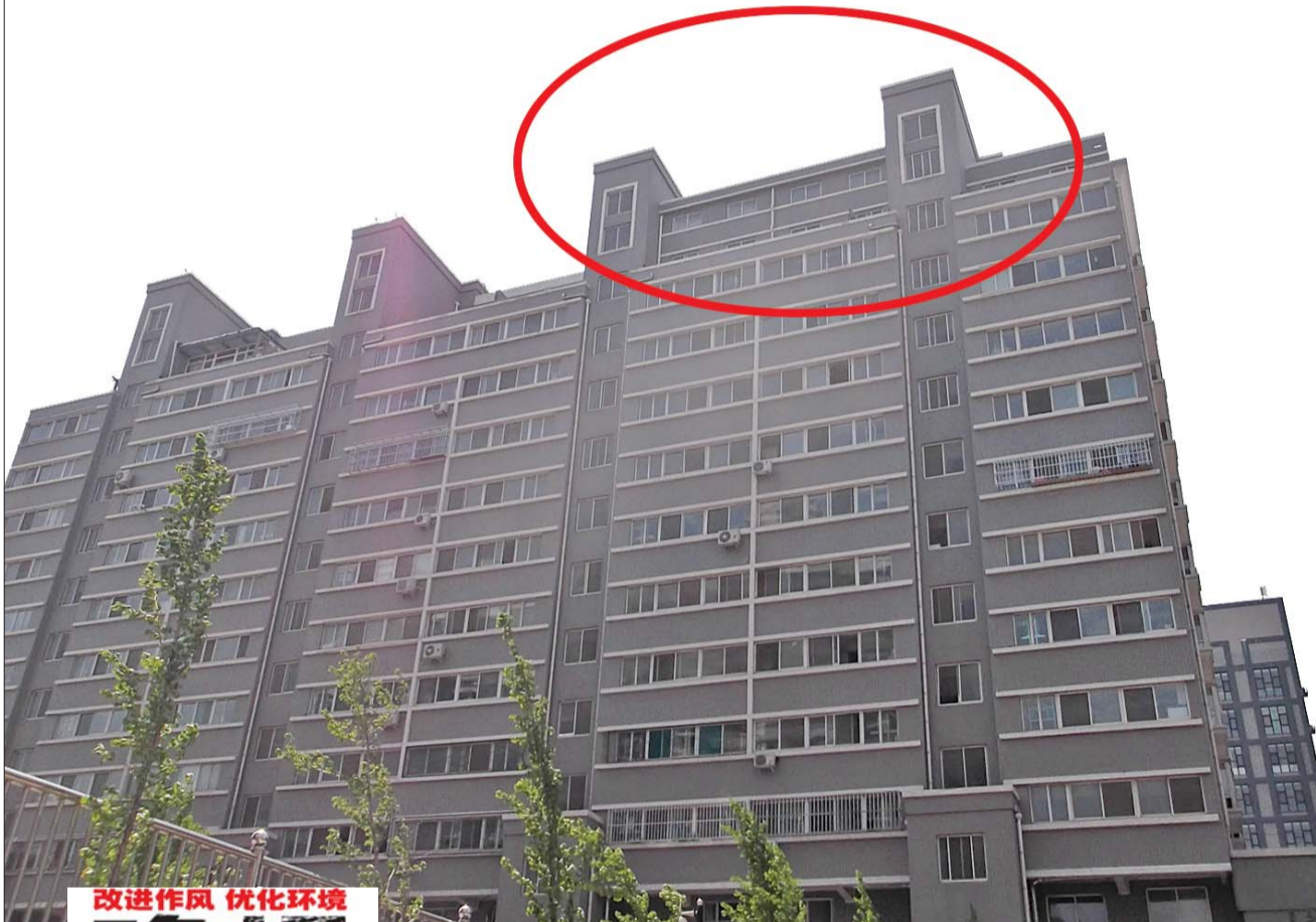
伟东新都二区19号楼两个单元上的楼顶外观明显不同。
