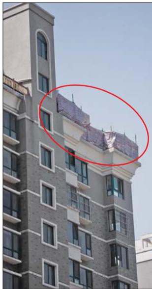
伟东新都二区16号楼西侧的楼顶正在施工。
