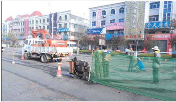
▲海港路施工现场。通讯员 宋宁 摄
