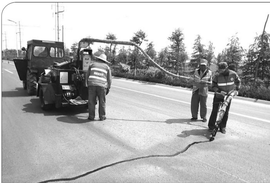
6日下午,公路养护人员对路面进行灌缝处理。 通讯员 林太红 摄
