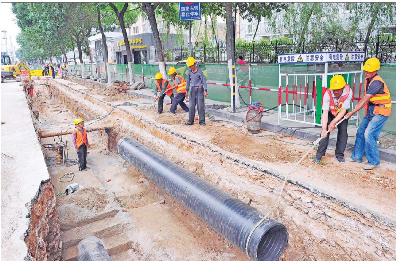
7日下午,施工人员在涿源大街东首北侧辅道铺设管线。 本报记者 邱志强 摄
