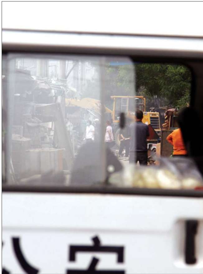
5月7日中午,公安、消防等部门对堤岭凌晨的火灾现场进行勘查清理。 本报记者 马志勇 摄
