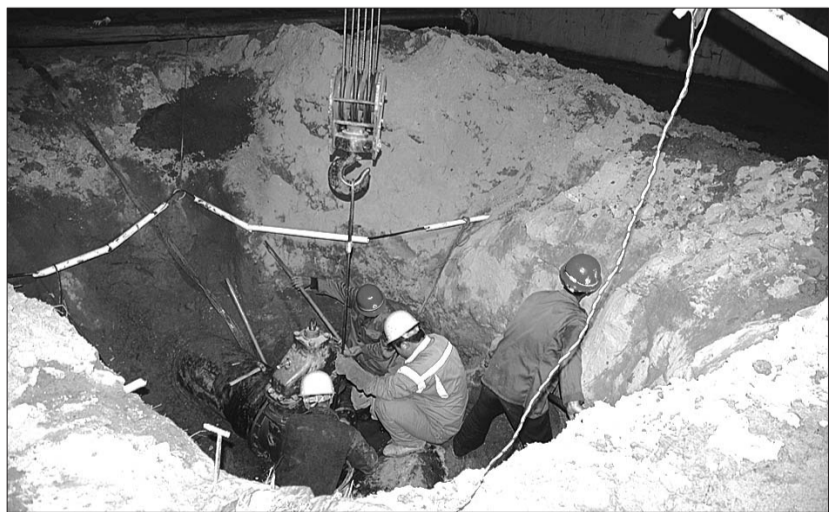
4日晚,施工人员加班到凌晨焊接供水管道。 本报通讯员 孟华 摄
