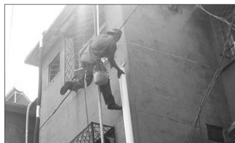
铁西邮电局宿舍内施工人员进行室外管道施工。 本报见习记者 甘倩茹 摄
