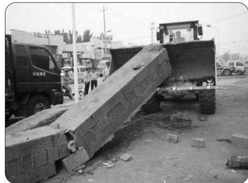
对道路两侧违章建筑进行拆除。 本报记者 袁沛民 摄
