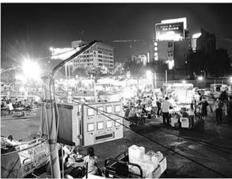
临时扯的电线随处可见。
