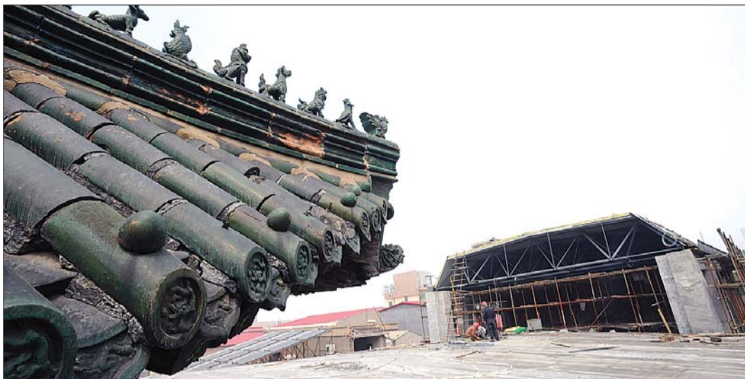
北洋大戏院舞台上方的钢承板已铺装完成。 本报记者 张中 摄
