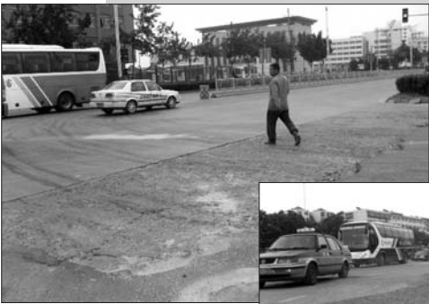
芝罘电路段,沙砾和草扇临时补修的坑洼地。
