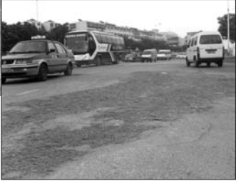
芝罘电路段,沙砾和草扇临时补修的坑洼地。
