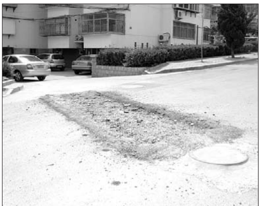
铺设下水管道后,未硬化的路面。记者 苑菲菲 摄
