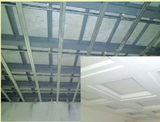
◆隔层施工前后对比图
