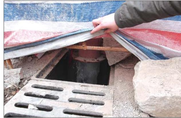
一工地降水将地下水直排下水道。热心市民提供 (摄于3月22日)
