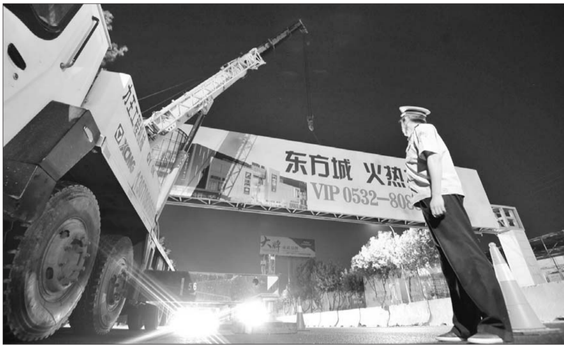
工作人员正在拆除“高炮”。本报记者 张晓鹏 摄
