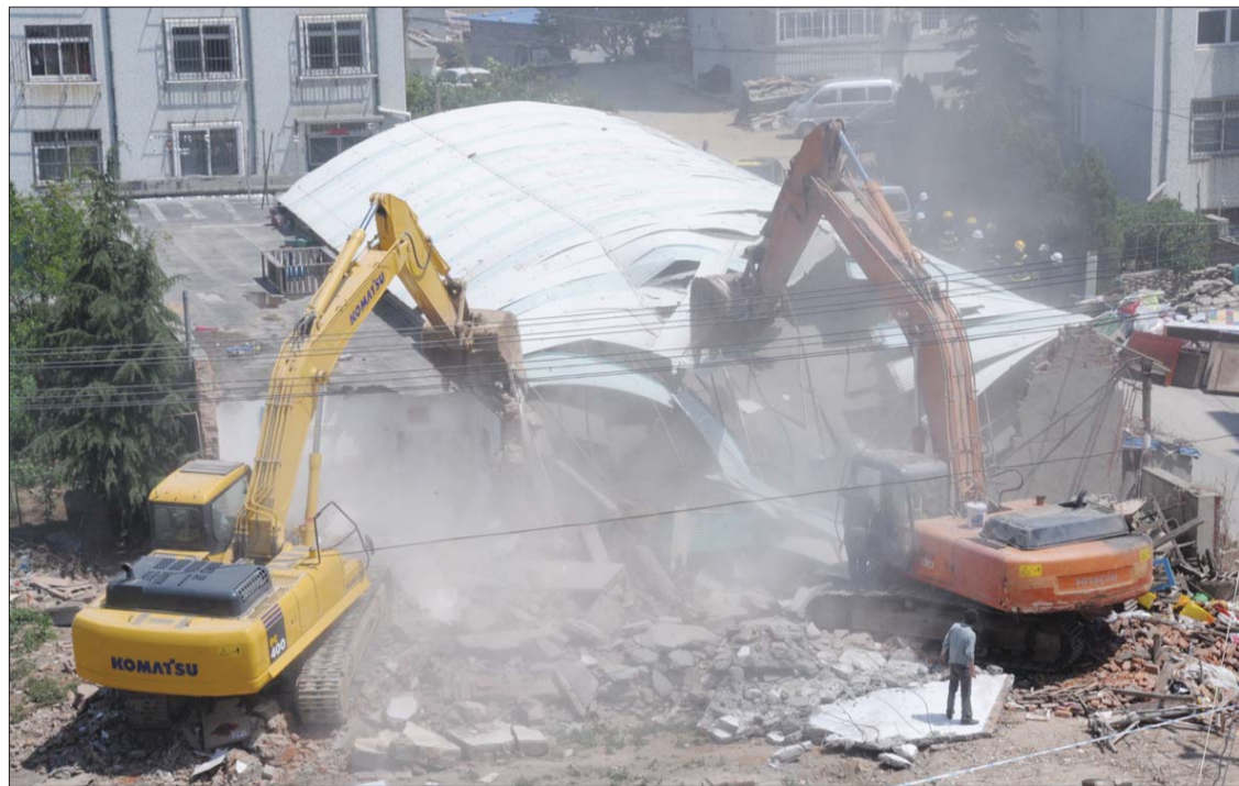
执法人员正在拆除违章房。本报记者 杨宁 摄
