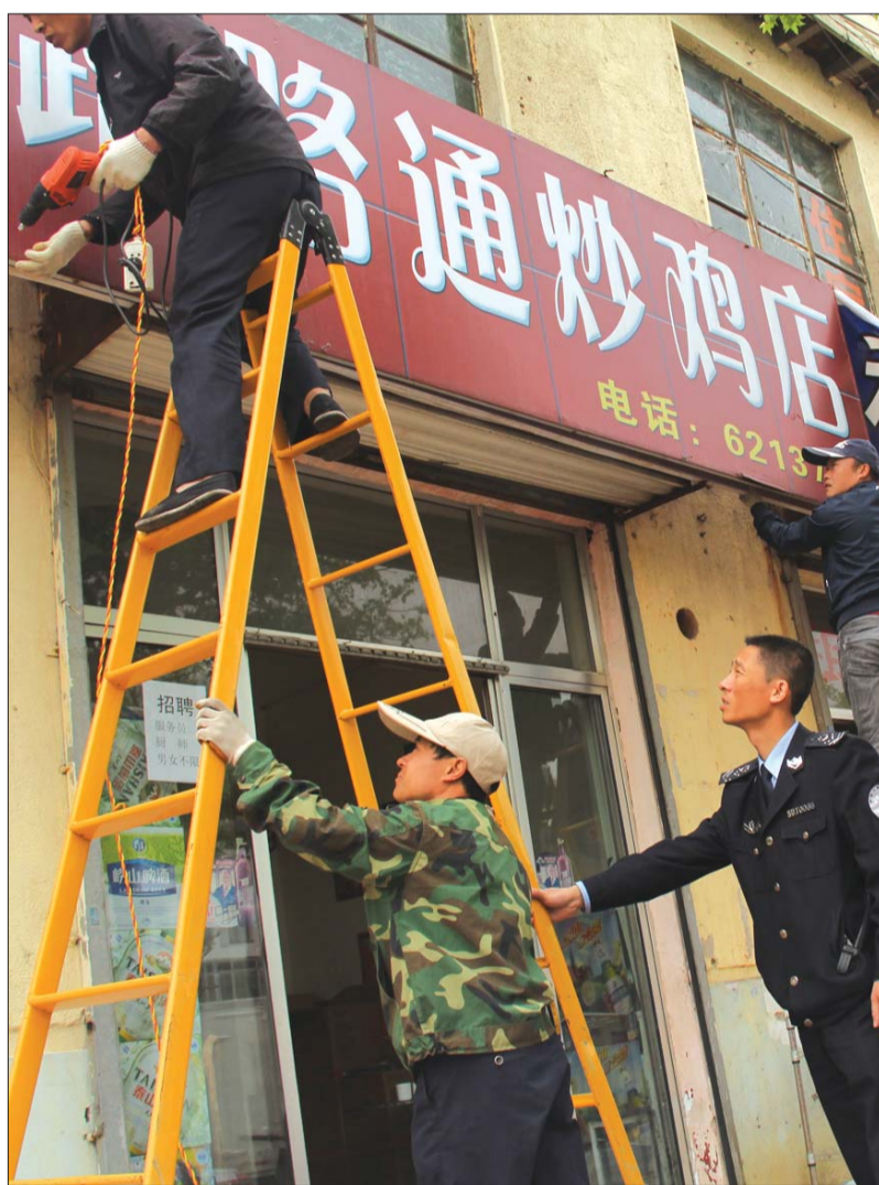
市城管执法局执法人员拆除违规广告牌。
