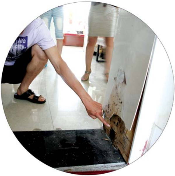
由于地暖漏水，王高建先生家的门框已经发霉，并且开裂。 本报记者 孙国祥 摄
