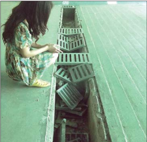
多数铁算子都已断裂掉落。 本报记者 刘志浩 摄
