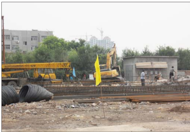
滨州嘉苑小区西南角已经开始施工。 记者 于荣花 摄
