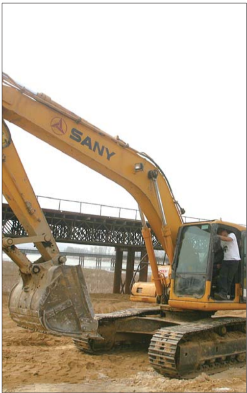
铁路桥工地上,一台挖掘机正在赶往另一地点施工。本报记者 赵金阳 摄
