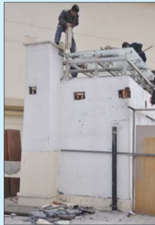
执法人员正在拆除通风井墙体。马健 摄
