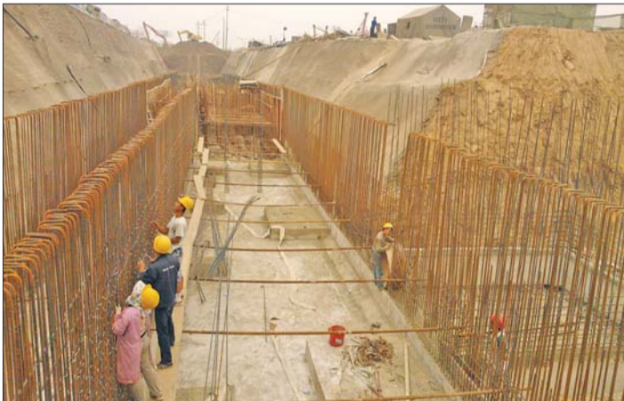
建设中的地下管廊。 本报记者 任志方 摄
