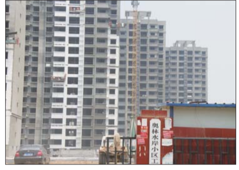
正在建设的奥林水岸小区。记者 张牟幸子 摄
