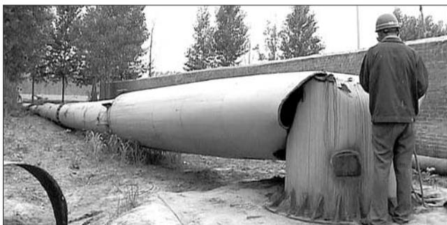
▲高约80米的烟囱被强制拆除并拖离厂区。(照片由东明县安监局提供)
