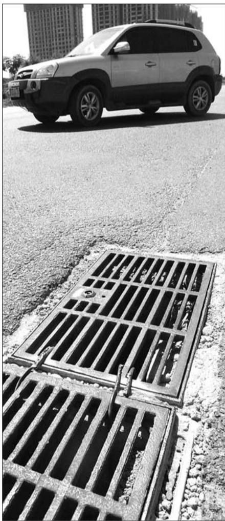
为防盗,一些铁制雨水算子用钢筋固定在地上。
