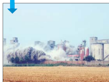
淘汰的水泥生产线被爆破拆除。
