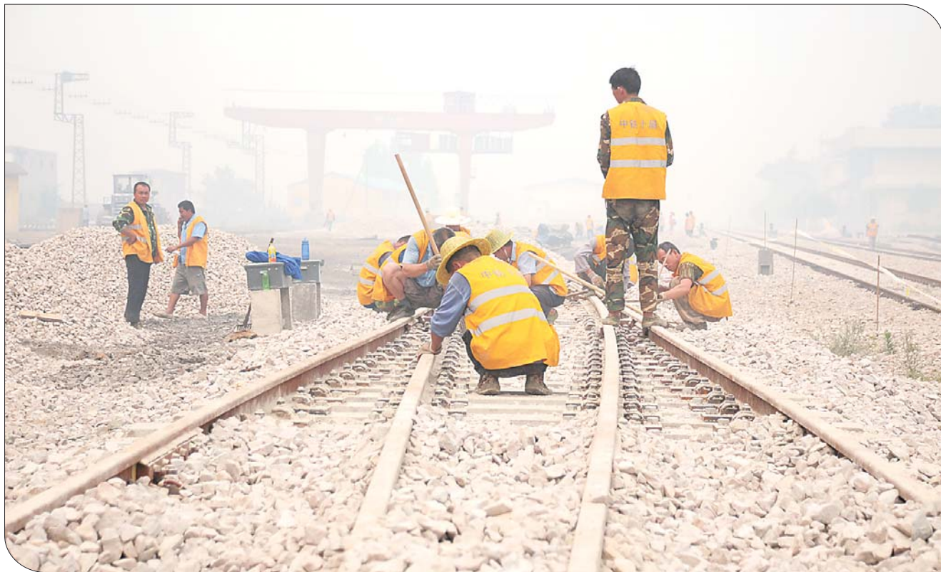
12日,工作人员正在对枣庄东车站附近的铁路进行施工。
