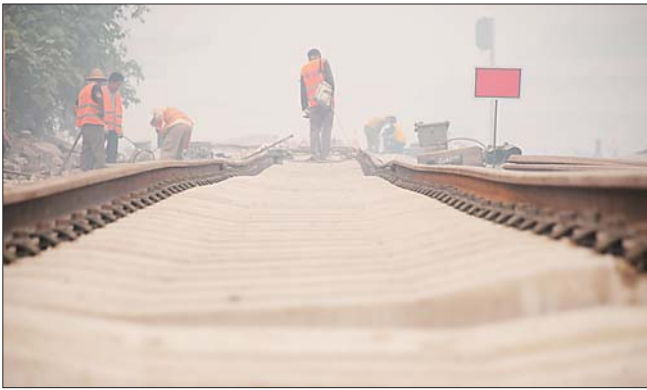
工作人员正在对枣庄东车站附近铁路进行施工。
