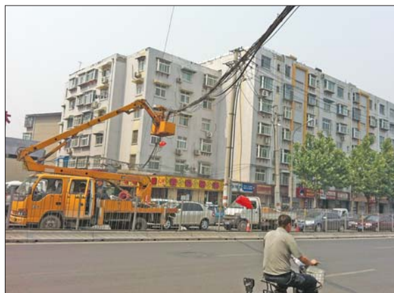
工程高空作业车升降臂升起,托着垂落下来的电缆线。
