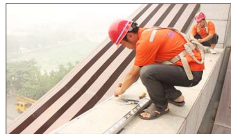
工作人员在安装LED护栏管和LED洗墙灯。 本报记者 张冬梅 摄
