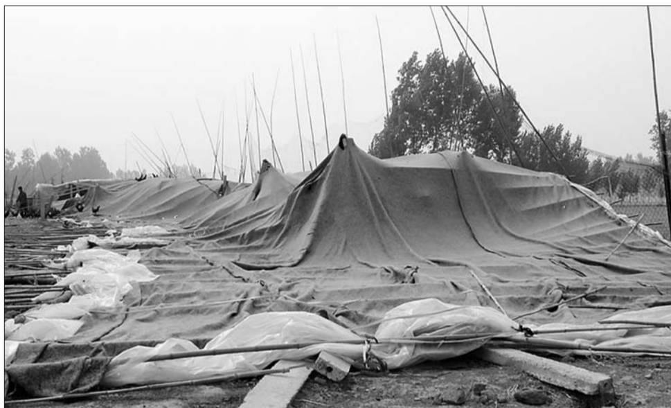
13日晚,聊城刮起8级大风,养鸡棚被刮塌。本报记者 凌文秀 摄
