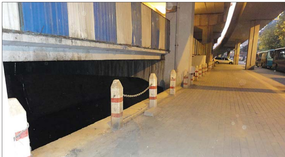
▲西泺河150米的河段,像这样缺失的护链就有10多段。见习记者 张泰来 摄
