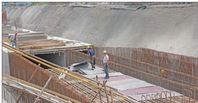
▲建设中的二环西路管线共同沟。记者 崔岩 摄
