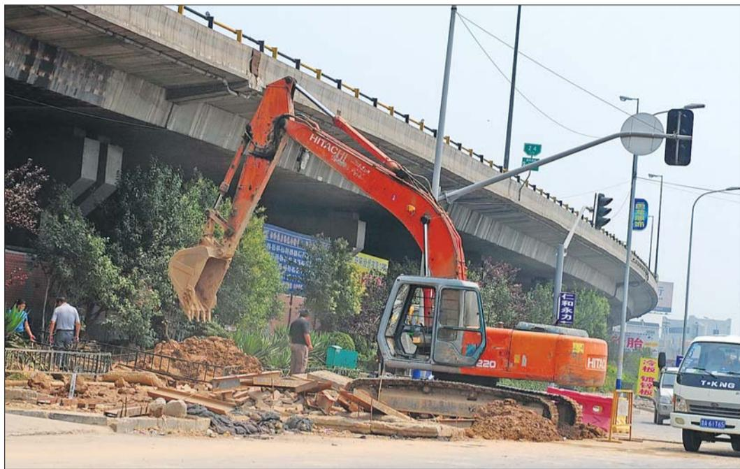
19日,二环北路盖家沟段,负责雨水管道施工的队伍在进行顶管施工作业,将雨水收集管道从北绕城高速公路地下顶到对面去,将路北的雨水导向小清河。 本报记者 周青先 摄
