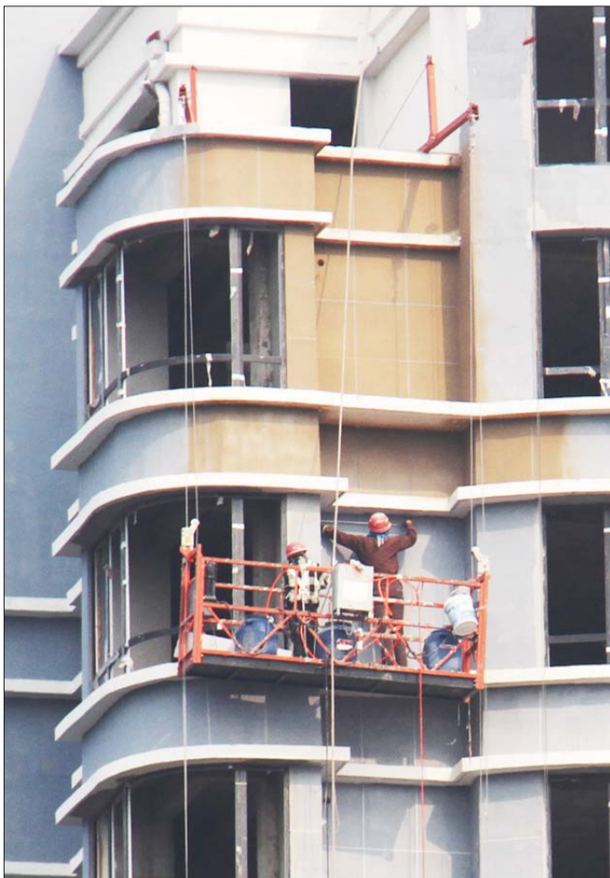
19日,在德州东方红路上的一处工地上,虽然午后的最高温度超过35℃,施工人员仍冒着高温户外高空作业。 本报记者 马志勇 摄
