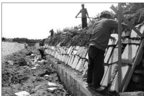
林前村村南,施工人员进行修建水渠。本报记者 李玉涛 摄
