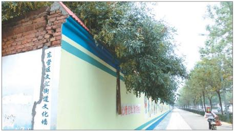
淄博路 南侧的文汇 社区文化墙 上能清晰地 看到墙体的 倾斜和墙上 的裂缝。 本报记者 段学虎 摄
