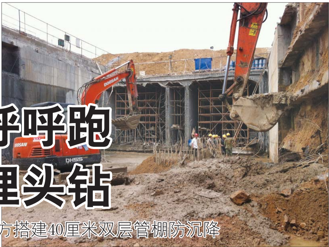
工作人员在已贯通的区域开展清理淤泥工作。
