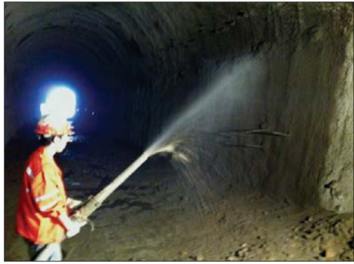
下穿胶济线贯通后,工作人员通过喷注混凝土,对墙体、拱顶进行支护巩固。
