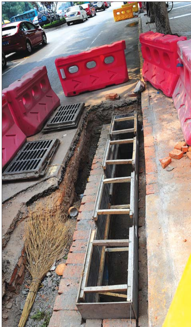
21日,济南冻源大街中段,施工单位已经更换了一些新的雨水井盖。 本报记者 周青先 摄
