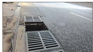
一个下水道井盖算子缺失。 拍摄地点:济南市历山路铁路桥下路东 拍摄时间:6月21日 拍摄人:济南读者刘先生
